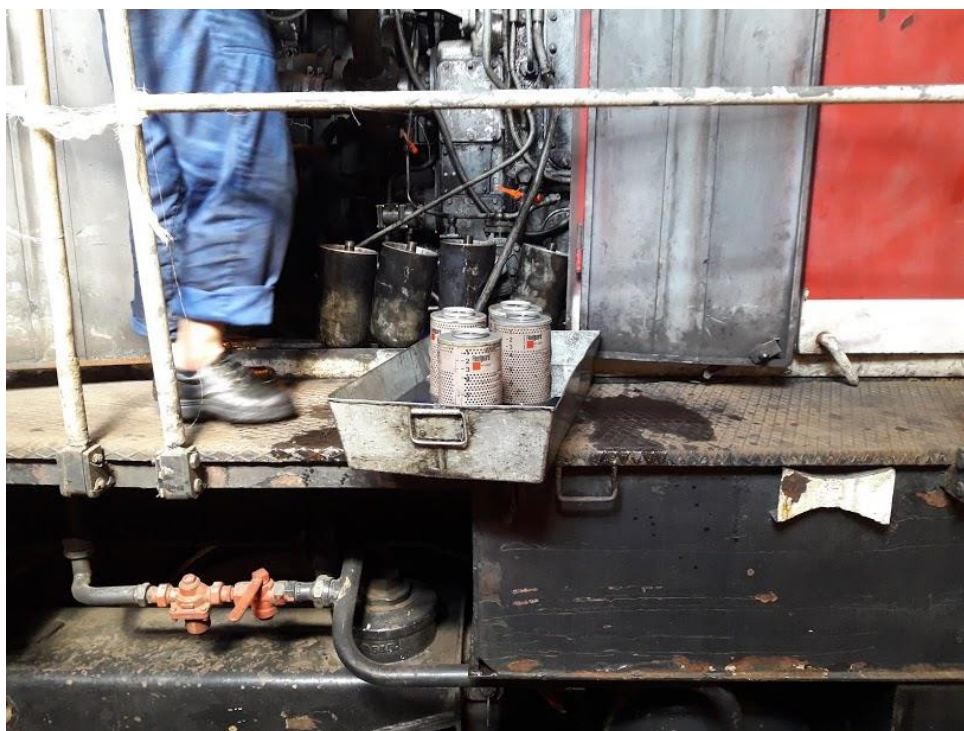
Hình 1.22. Bộ lọc đã được thay
