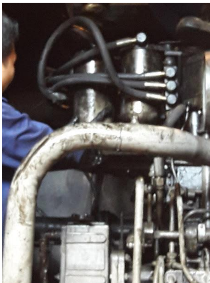
Hình 1.21. Thay 04 bộ lọc dầu sau khi chạy rô đa phụ gia
