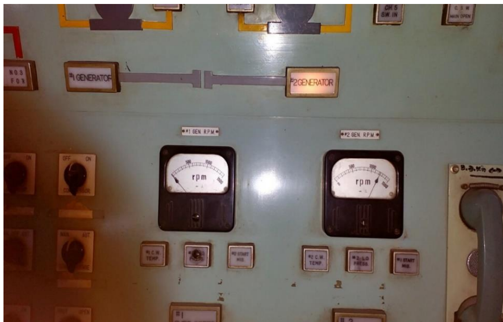
Hình 1.8. Đồng hồ đo vòng quay của động cơ
